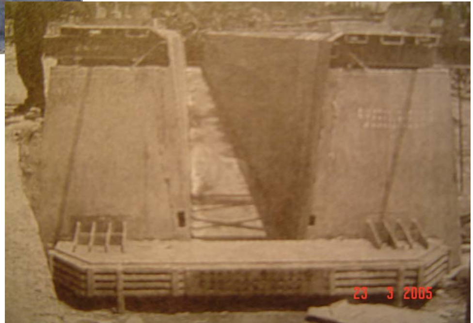
Hình 8: Bệ căng cốt thép dầm super T
