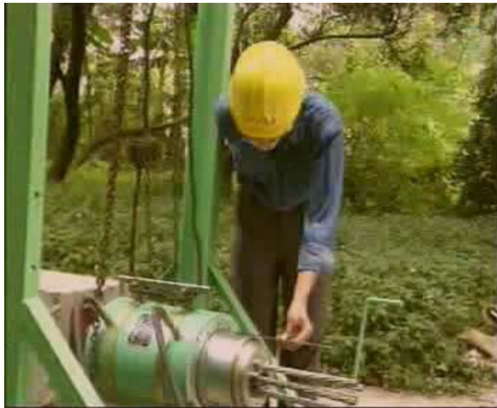
Hình 10: Chế tạo dầm BTCT UST căng sau
