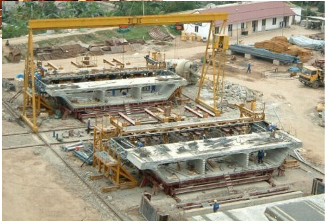
Hình 12: Chế tạo các đoạn dầm (short line) cầu Kiên
