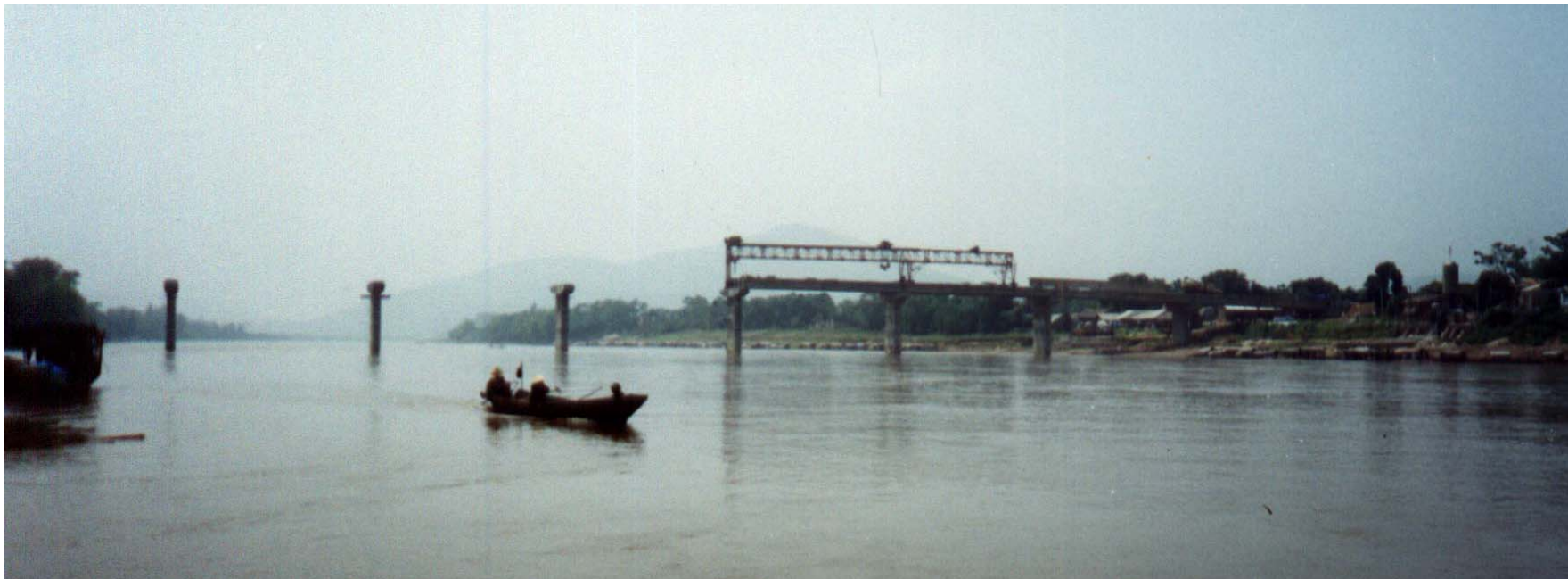
Hình 28: Thi công cầu trên đường Trường Sơn bằng tổ hợp mút thừa
