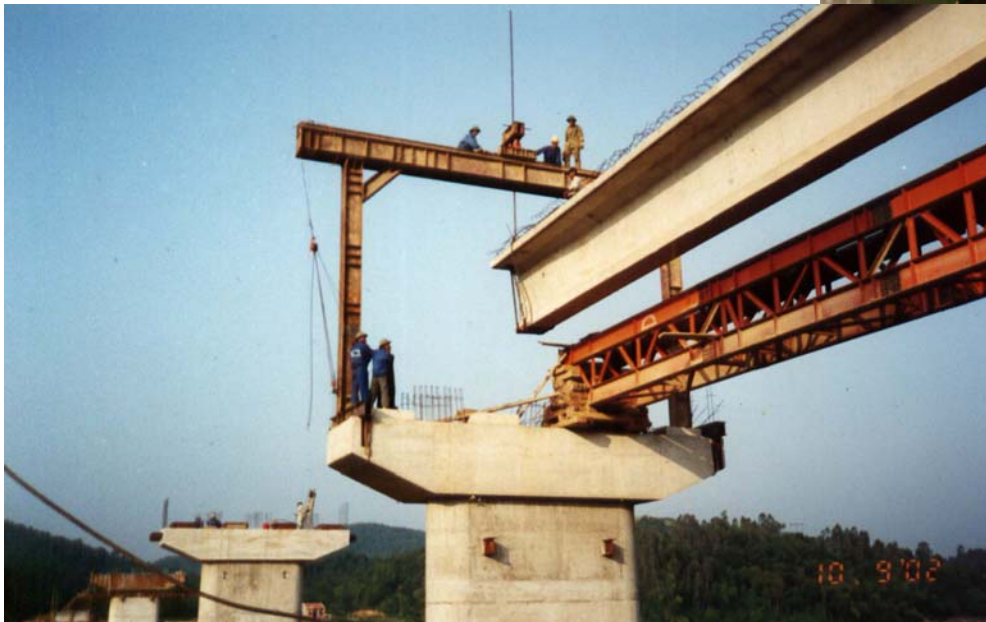
Hình 26: Lao dầm bằng các giá sàng ngang và dầm dẫn
