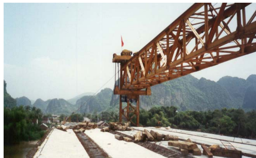
Hình 29: Thi công cầu bằng tổ hợp mọt thừa
