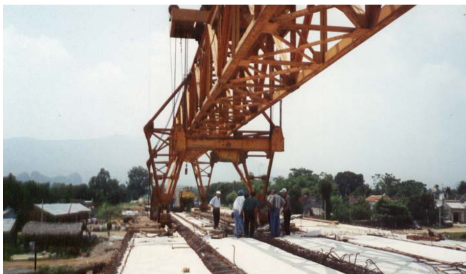
Hình 29: Thi công cầu bằng tổ hợp mọt thừa
