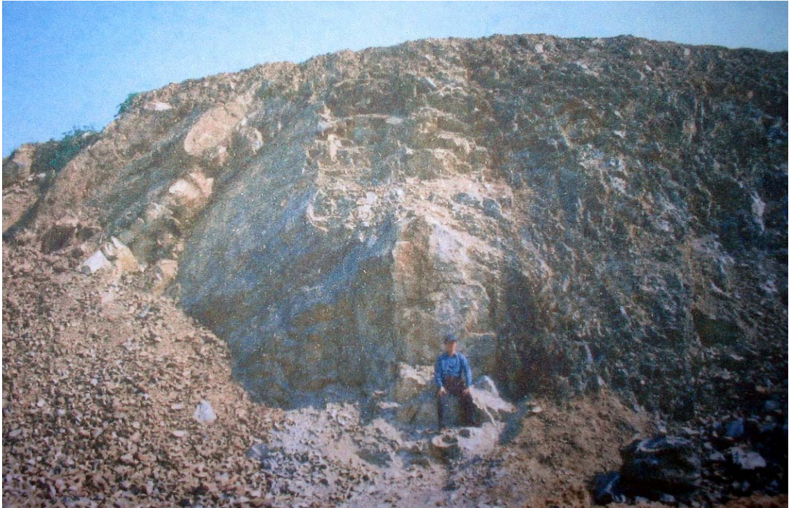
Trượt lở đất đá do hoạt động địa chất
