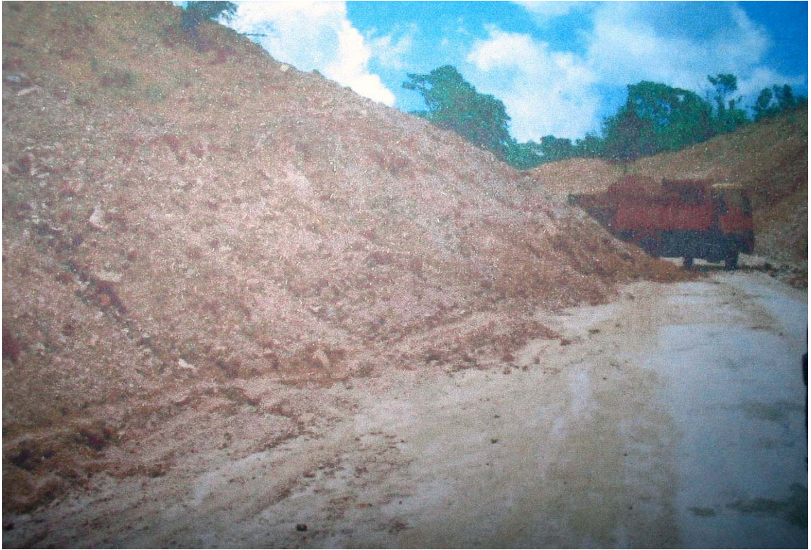
Taluy bị sạt lở trong mùa mưa
