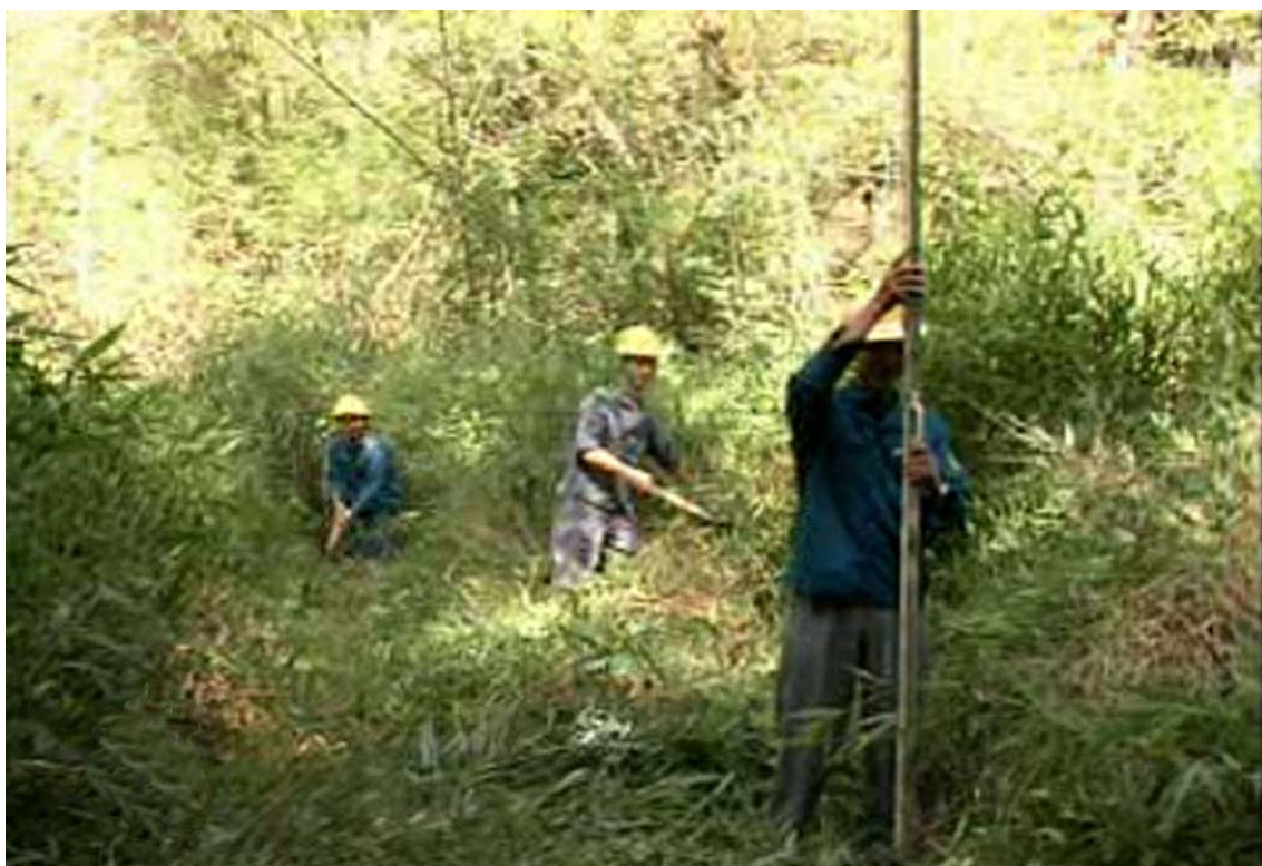
Chuẩn bị cho công trường xây dựng đường
