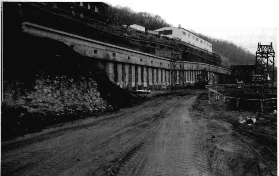
Gia cố mái dốc của đường ở thành phố Praha, cộng hòa Séc
