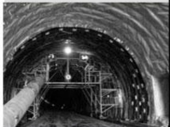
Hình 1. Ống thông gió khi thi công công trình ngầm
