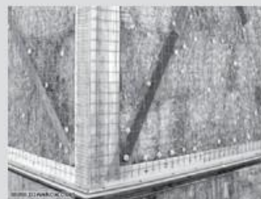
Rơm rạ được ép chặt vào nhau bằng gỗ và khung sắt. (Ảnh: CNN)
