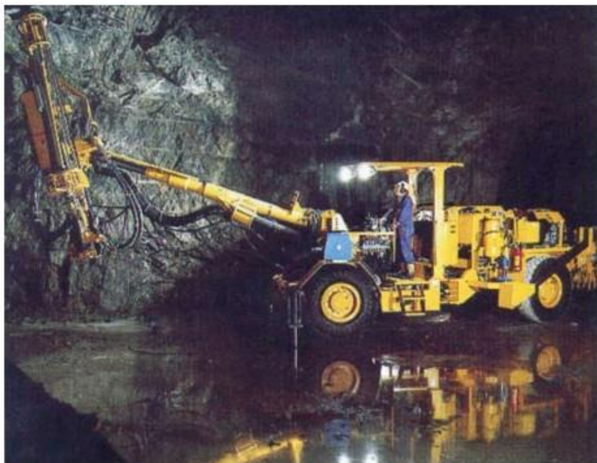
Máy khoan hầm Boltec 335 hãng Atlascopco Thủy Điện sản xuất
