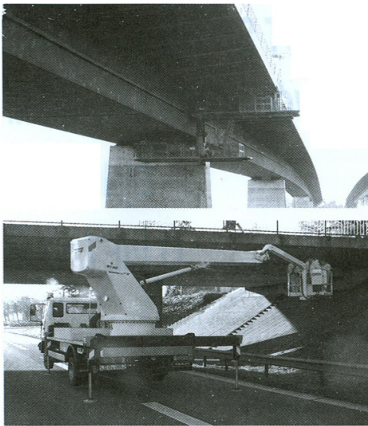
Hình 1, 2. Sử dụng xe thang trong kiểm tra cầu
