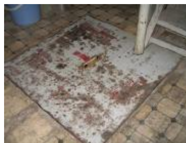
Hình 4. Bể điều hòa
