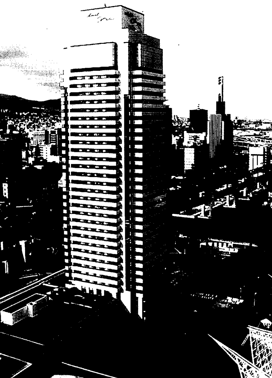
Nhà cao tầng ở thành phố ở Bangkok - Thái Lan
