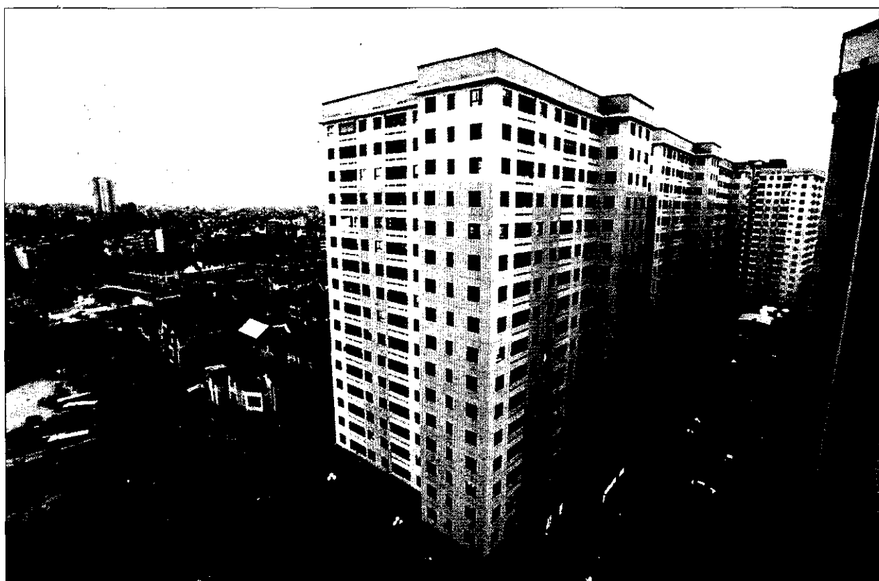
Nhà cao tầng tại khu ĐTM Trung Hoà - Nhân Chính (Hà Nội)
